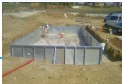
Installazione della struttura con pannelli sopra platea in cemento armato
